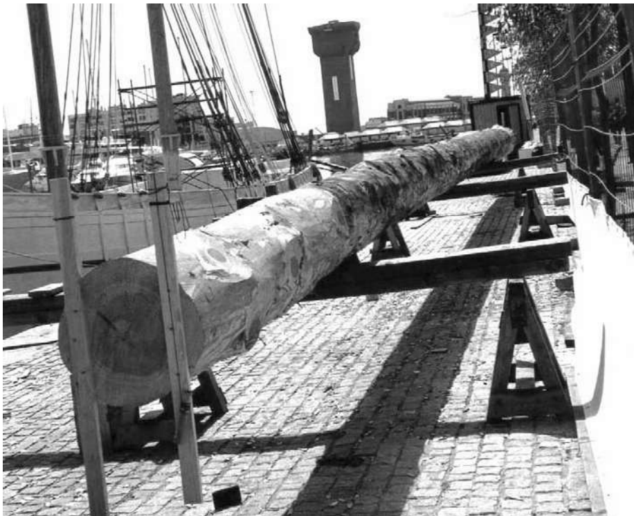
Figuur 9.2 - Een pailebote-stick Santa Eulalia voorbereid om te worden gestyled. Let op de twee ribben die verticaal aan het uiteinde zijn genageld en die dienen om de koorden te ondersteunen die worden gebruikt gidsen om de kofferbak vierkant te maken. Foto van C. Hormaechea.
